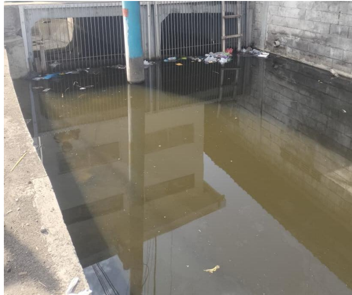
Gambar 11 Saluran Drainase Hulu Segmen 4 STA 1+180 656°34.44''LS dan 110°30'17.63''BT (Sumber : Dokumentasi Pribadi)
