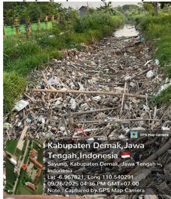
Gambar 1 Kondisi Saluran Drainase Lokal Prampelan (Sumber: Dokumentasi Pribadi, 2025)
