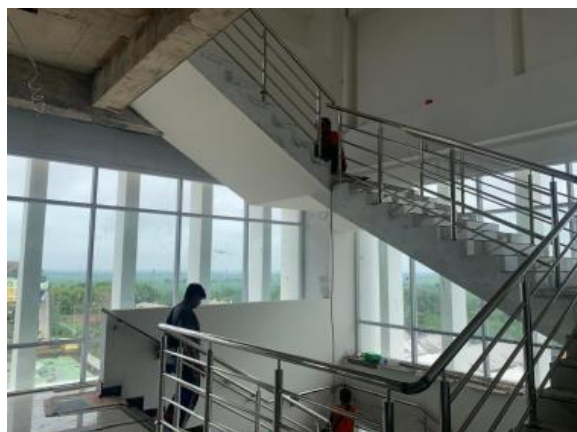
Gambar 4. 9 Pekerjaan Railing Tangga
