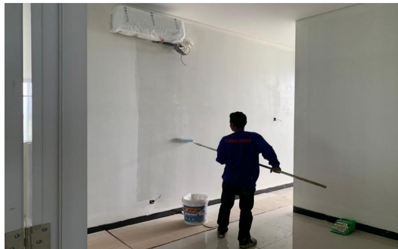
Gambar 4. 11 Pekerjaan Pengecatan dinding
