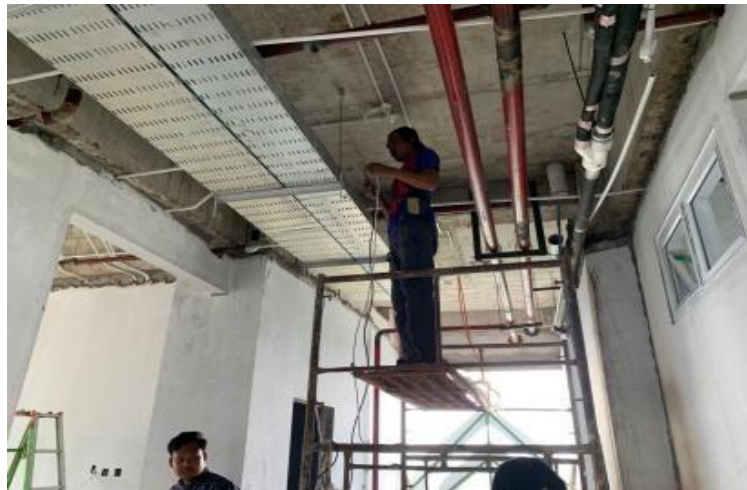
Gambar 4. 8 Pekerjaan Instalasi Tata Suara
