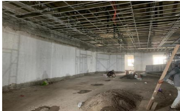
Gambar 4. 5 Pekerjaan Plesteran Lantai
