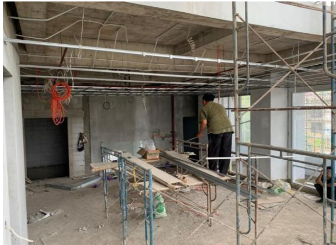
Gambar 4. 3 Pekerjaan Pemasangan Rangka Plafond
