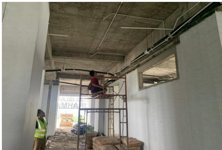
Gambar 4. 4 Pekerjaan Instalasi Kabel
