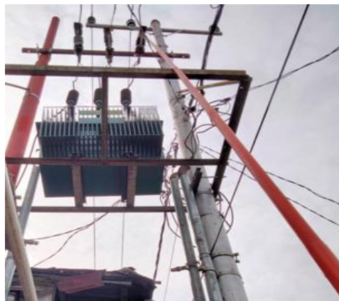
Gambar 4. 1 Pelepasan FCO Dari LBS Menggunakan Telescopic Hot Stick
