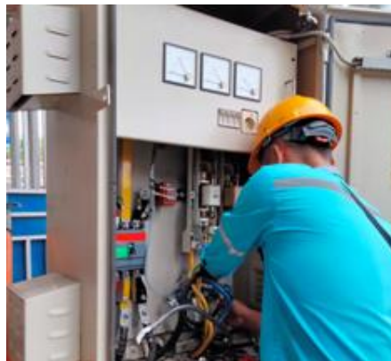
Gambar 4. 3 Penggantian dan Pemasangan Kembali Kabel JTR Yang Rusak Dengan Kabel JTR Yang Baru
