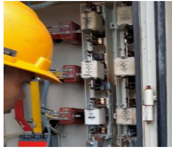
Gambar 4. 4 Setelah NH Fuse Yang Baru Di Pasang Kembali
