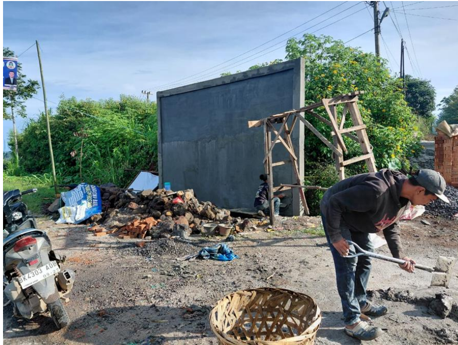
Gambar 3. Tahap pembangunan struktur gapura desa.
